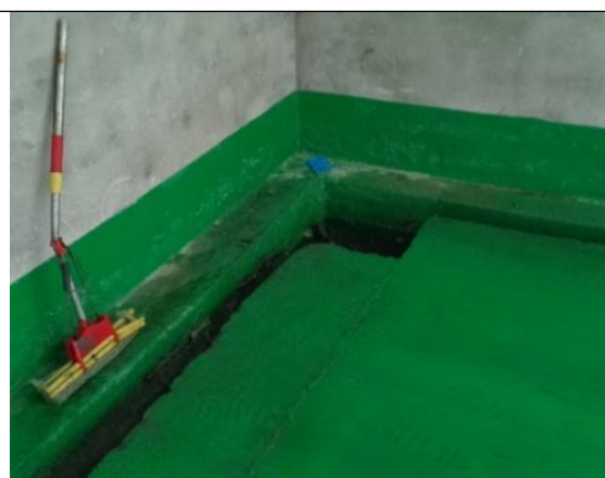
危废仓库地面防腐防渗
